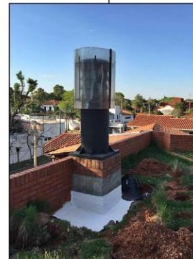
FOTO J AISLACION EN LA BASE DEL CORONAMIENTO
