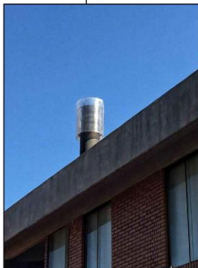
FOTO H AREA DE COLECTOR SOLAR ABERTURA HUECO DE SALIDA DE AIRE: SECCION CIRCULAR DIMENSIONES: ALTURA: 1,50 MTS.
